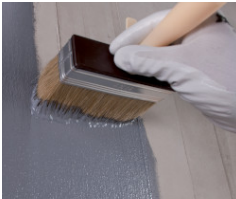
Eco Prim Grip Plus felhordása betonra ecsettel
