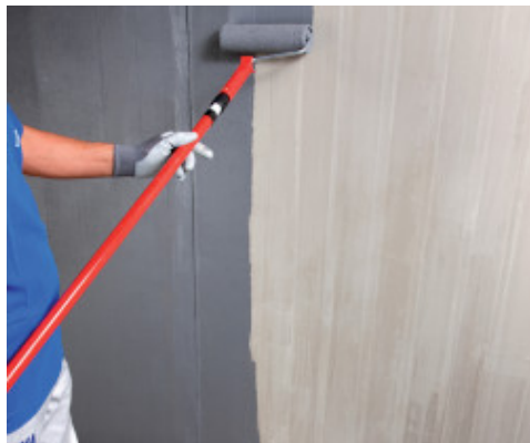
Eco Prim Grip Plus felhordása betonra hengerrel
